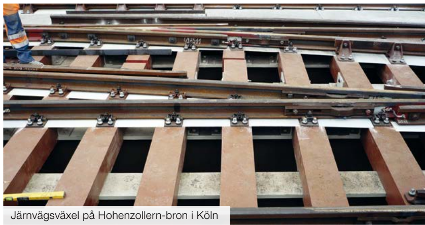
Specialinfästning av FFU-slipar på en azurblå stålkonstruktion
