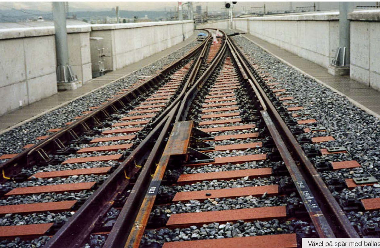
Växel på ballastfritt spår, fastskruvad, på gummfötter
