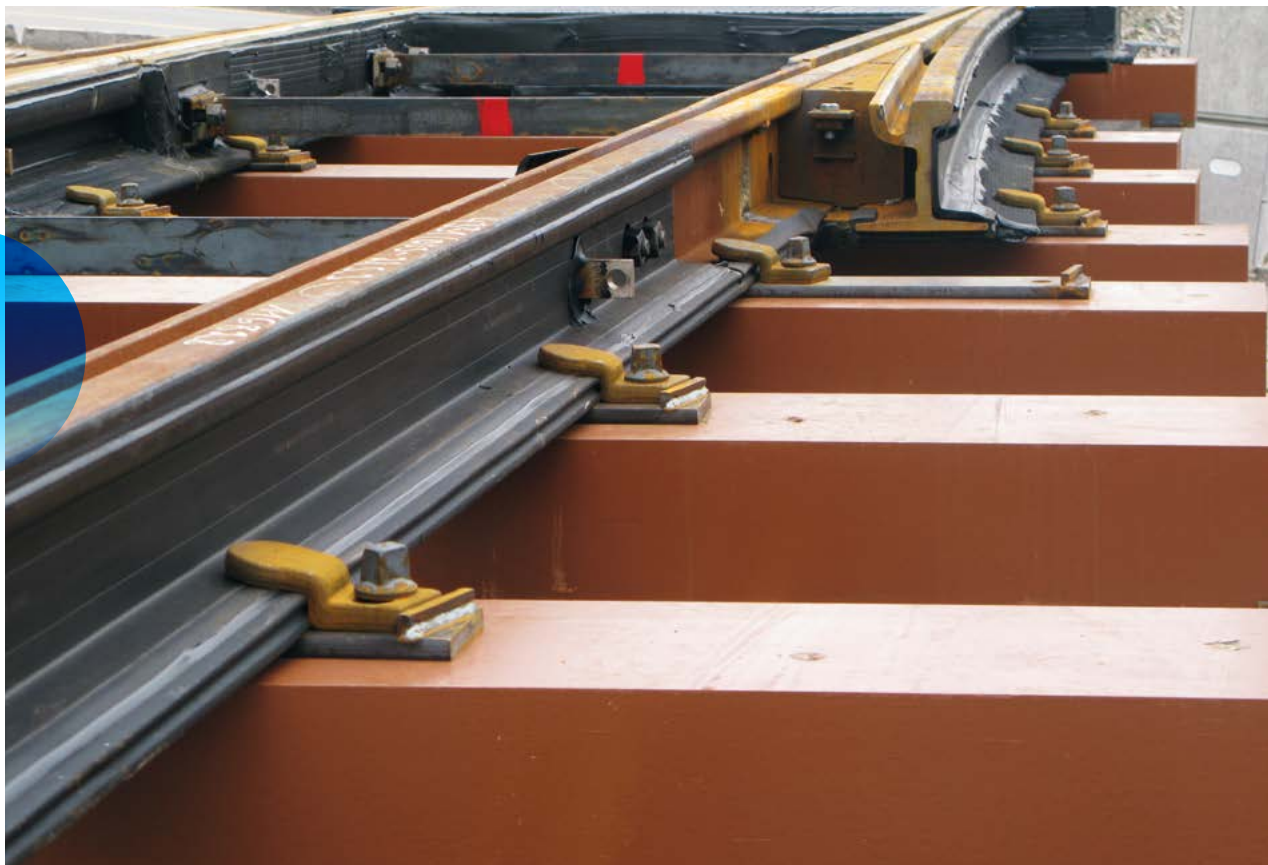
MVV München | Infästning av „Rheinfeder“ vid FFU-slipar
