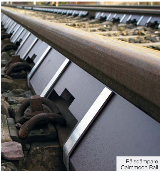
Rälsdämpare Calmmoon Rail på ett spår tillhörande Tyska Järnvägar
